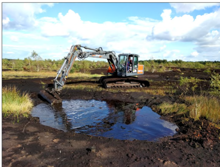
Für seltene Hochmoorarten werden Schlenken von ca. 5 m Durchmesser und ca. 50 cm Tiefe angelegt
