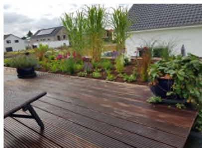
Gründach mit Terrasse auf Doppelgaragenneubau
