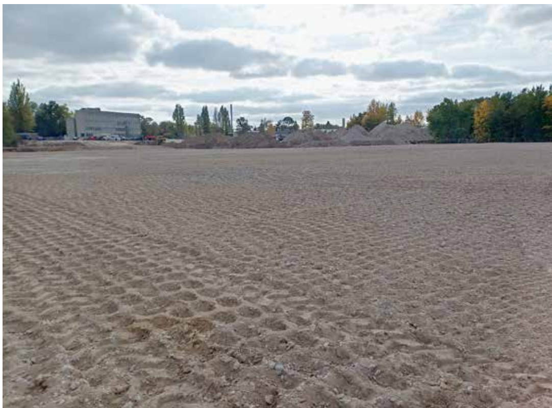
Fertiges Planum im ersten Teilabschnitt, im Hintergrund die Boden- und RC-Haufwerke aus dem zweiten Bauabschnitt
