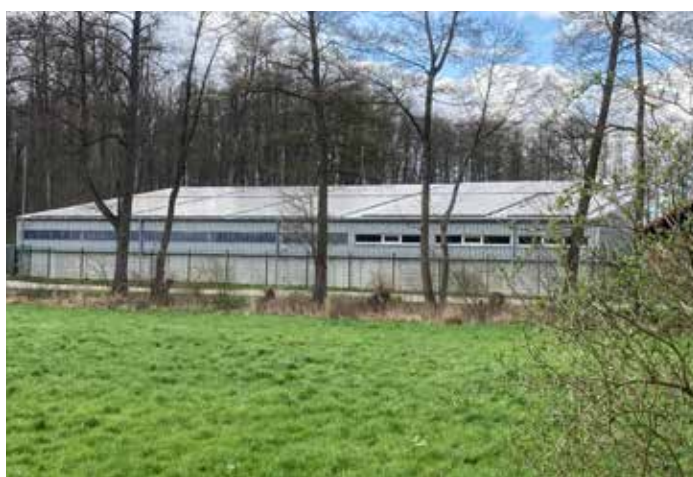
Kläranlage Bissendorf: Photovoltaikmodule auf der Schlammhalde
