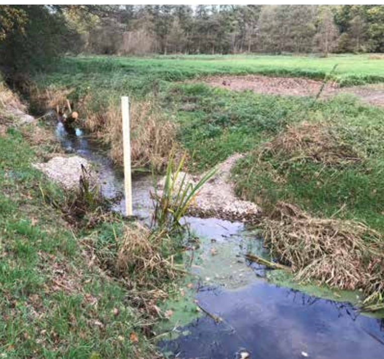
Versetzte Kiesschüttung mit Strömunglenker sowie Baupiegel zur Überwachung der Wasserstände bei Niedrigwasser
