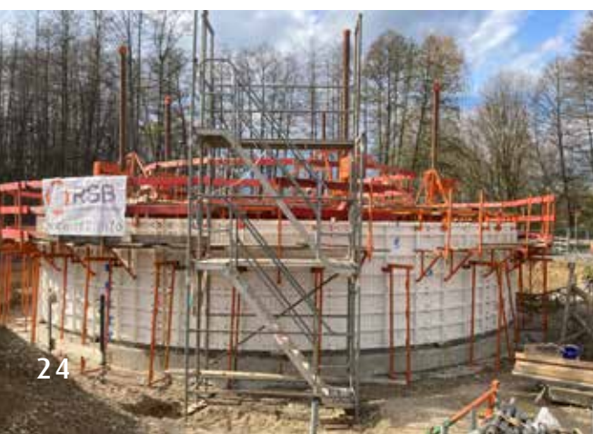
Kläranlage Bissendorf: Faulschlammbehälter im Bau
