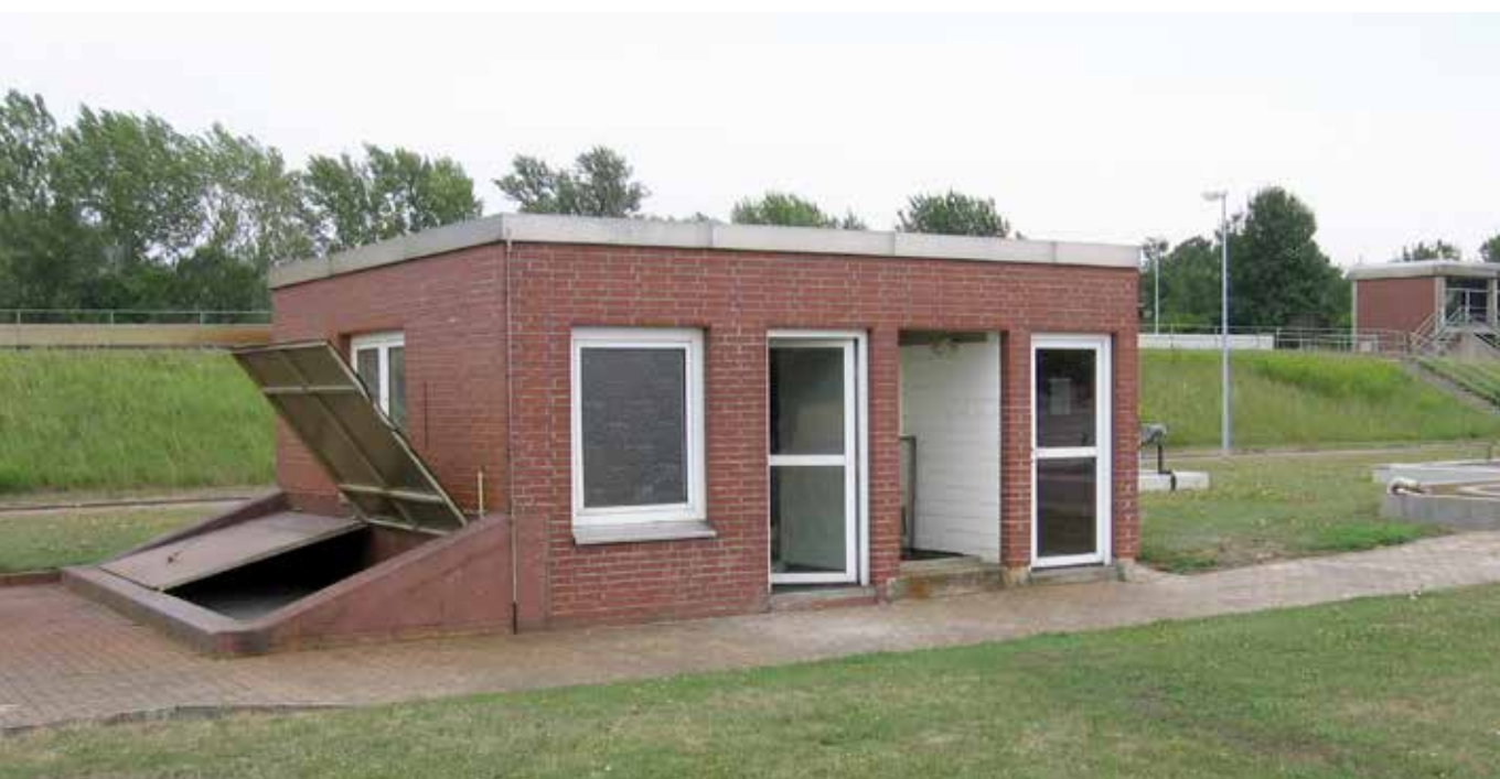
Annahme Fällmittelstation Gruppenklärwerk Großgoltern
