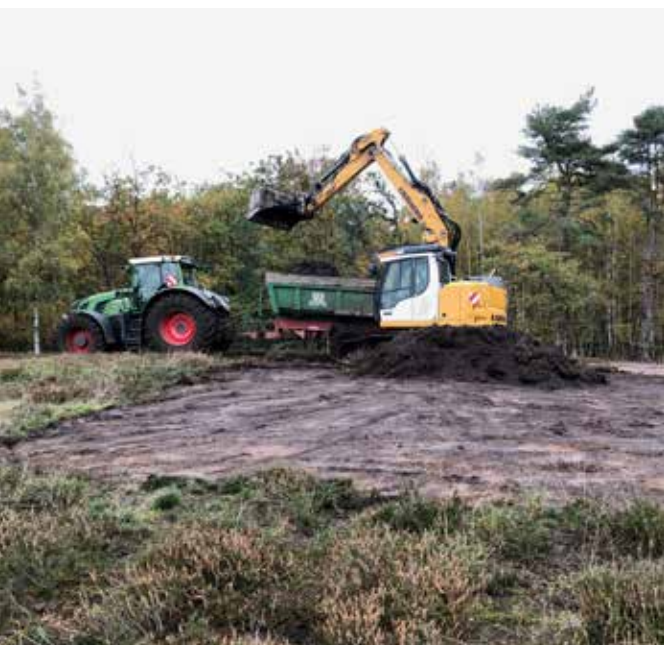
Plaggen der Fläche mit einem Bagger
