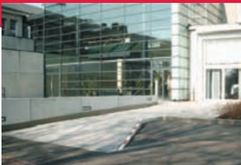
HANNOVER CONGRESS CENTRUM FLACHE RAMPE AUF DIE TERRASSE
