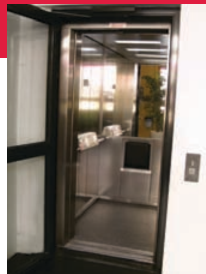
IGS RODERBRUCH AUFZUG MIT TABLEAU, KLAPPSITZ UND SPIEGEL
