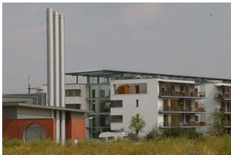
Figure 11 : Centrale de cogénération décentralisée
