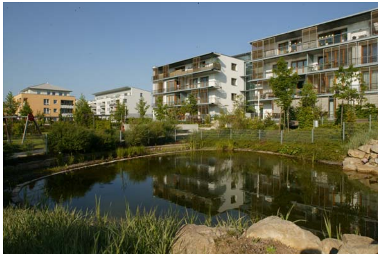
Figure 12 : Bassin de rétention dans une cour intérieure
