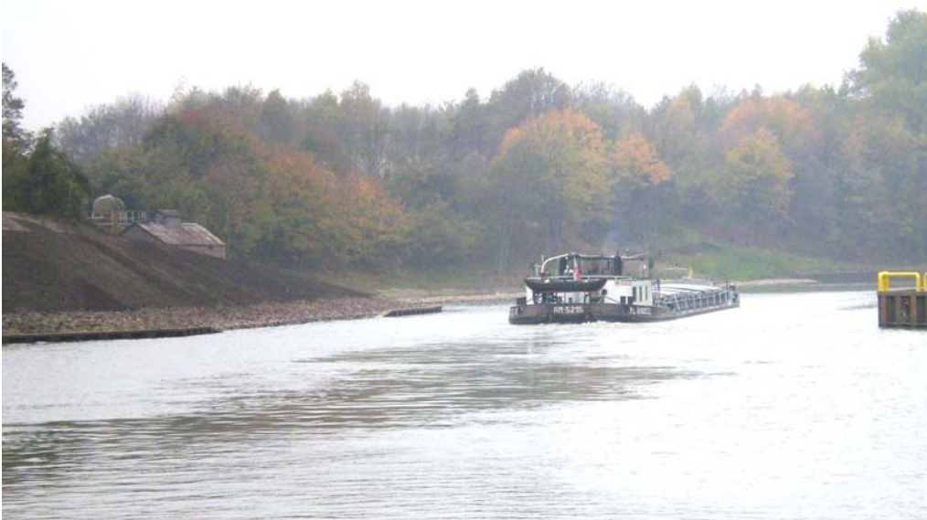
Ausgebauter SKM – Blick von der Wendestelle in dem SKM; Im Hintergrund der ehemalige Ölhafen Foto: NBA Hannover
