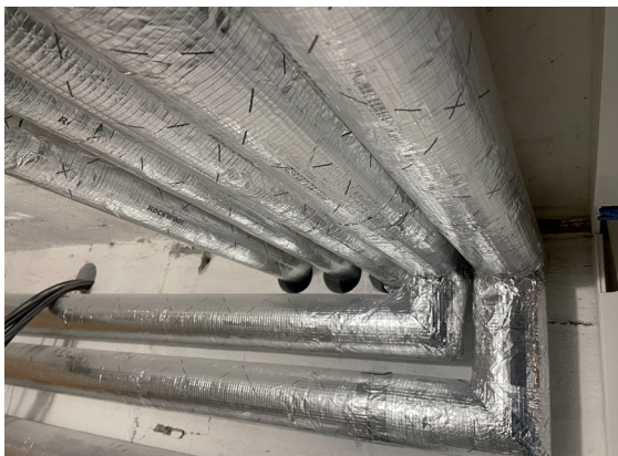
Gedämmte Kellerleitungen
