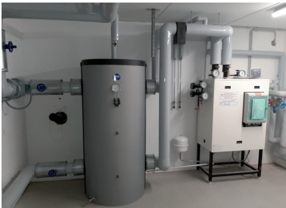
Fernwärme-Kompaktstation mit Wärmespeicher
