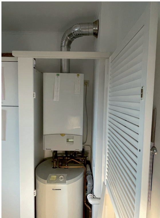
Gastetagenheizung mit indirekt beheiztem Speicher
