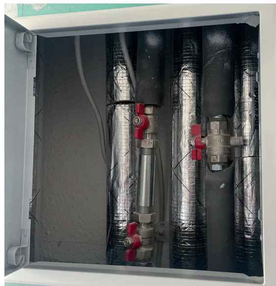
Verteilstränge im Schacht
