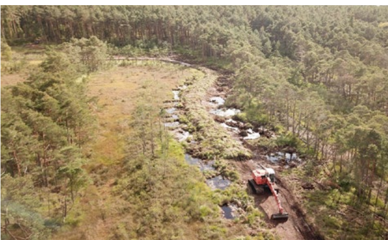
Abb 3: Bau eines Torf-Dammes im Otternhagener Moor in 2022
