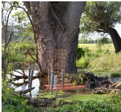
Abb. 3: Neu angelegte Dammdrainage zur Kontrolle des maximalen Wasserstandes
