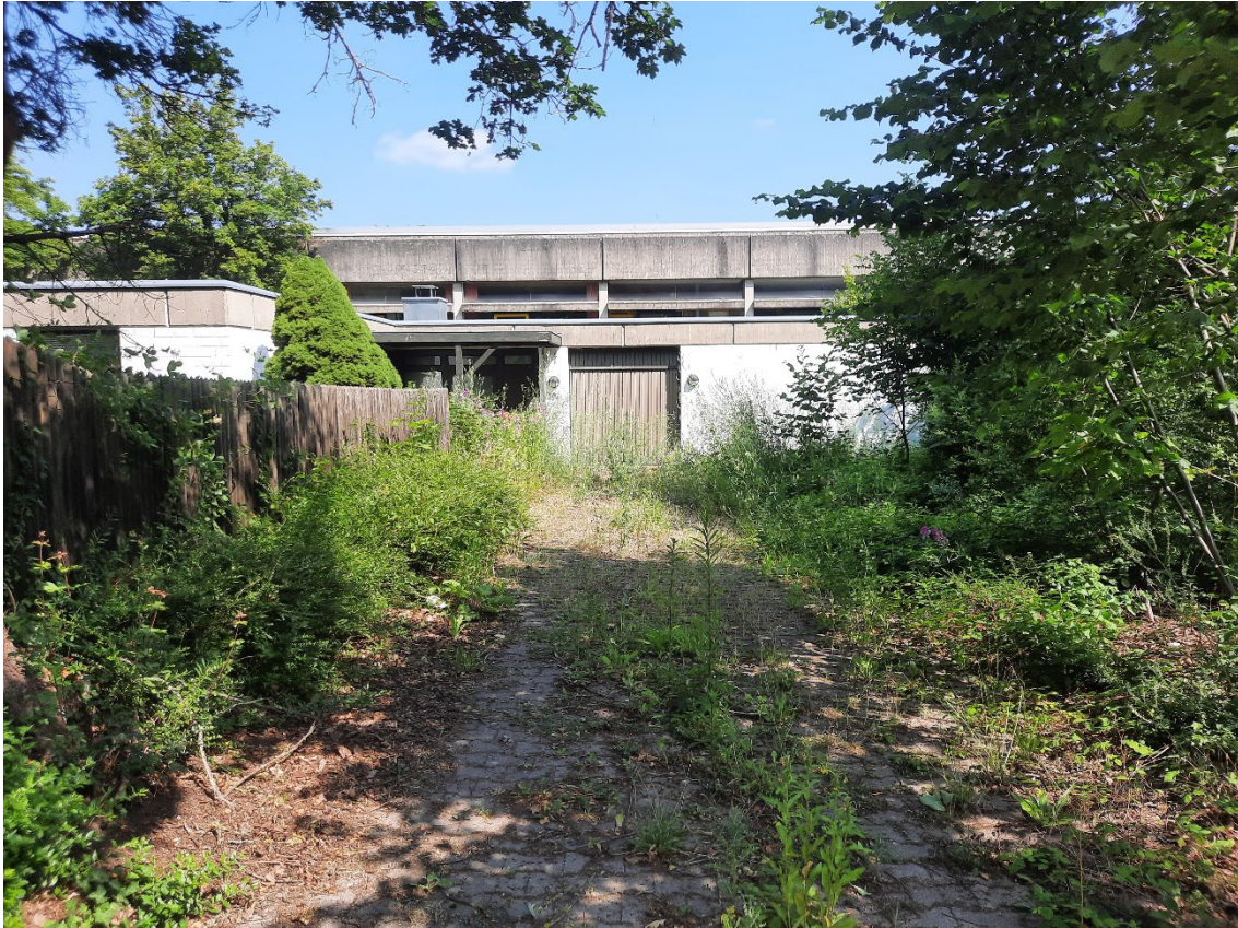
Abb. 3-2: Einfahrt zur leerstehenden Hausmeisterwohnung mit deutlich erkennbarer Sukzession durch Ruderalzeiger und Gehölze
