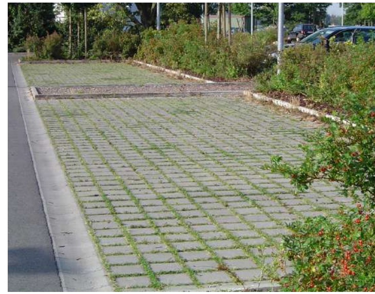
Stellplatzpflaster mit Sickerfugen
