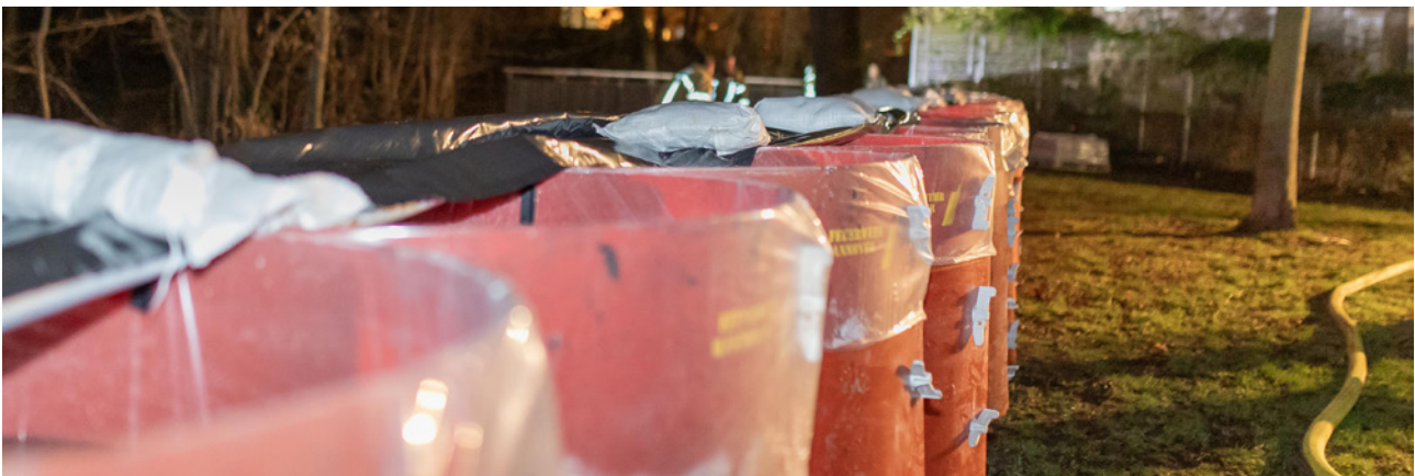
Das mobile Deichsystem AQUARIWA im Einsatz
