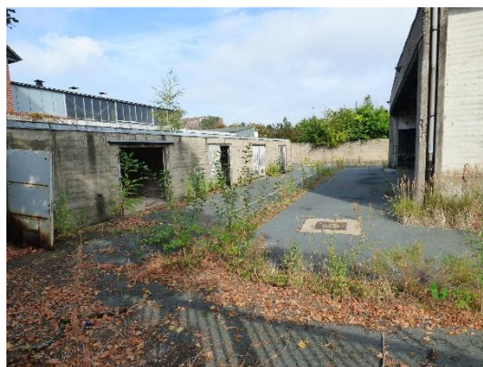
Abb. 10 Gebäude des ehemaligen Wertstoffhofes im Plangebiet.
