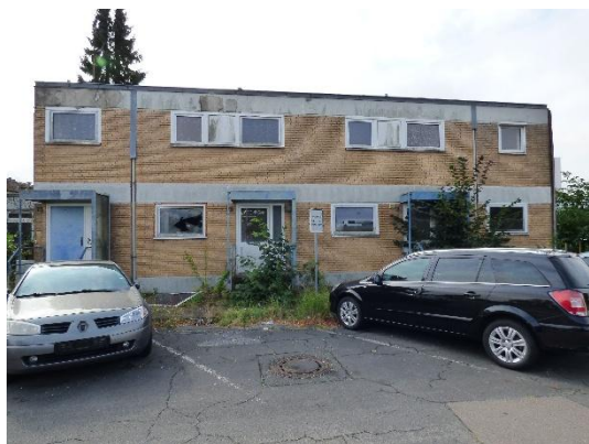
Abb. 9 Gebäude des ehemaligen Wertstoffhofes im Plangebiet.
