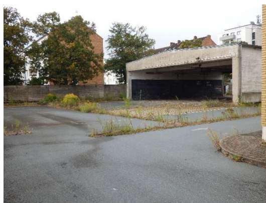
Abb. 8 Gebäude des ehemaligen Wertstoffhofes im Plangebiet.
