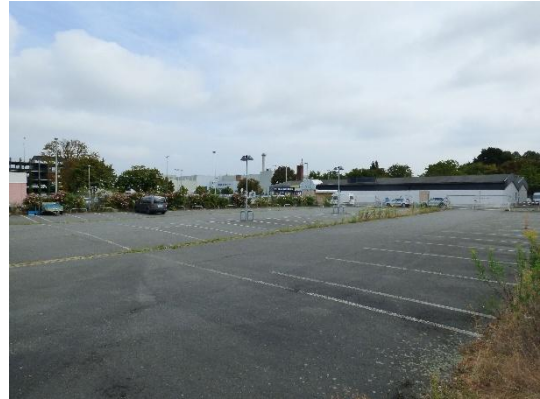
Abb. 5 Parkplatz im Plangebiet.
