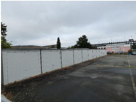
Abb. 6 Garagenkomplex im Plangebiet.
