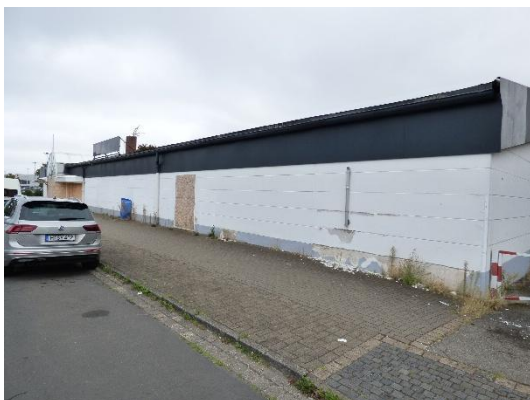
Abb. 18 Westliche Fassade des ehemaligen Lebensmittelmarktes.
