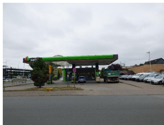
Abb. 11 Tankstelle im Westen des Plangebietes.
