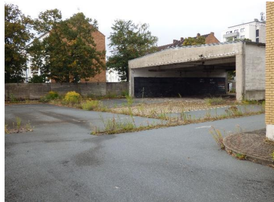
Abb. 7 Gebäude des ehemaligen Wertstoffhofes im Plangebiet.
