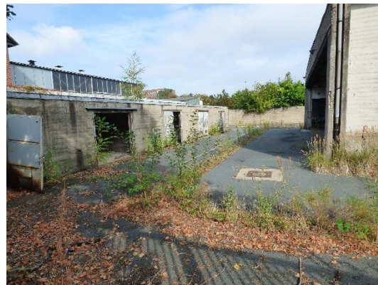
Abb. 9 Gebäude des ehemaligen Wertstoffhofes im Plangebiet.
