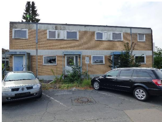
Abb. 8 Gebäude des ehemaligen Wertstoffhofes im Plangebiet.
