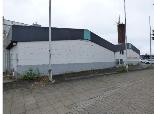
Abb. 15 Blick auf die nördliche Fassade des ehemaligen Lebensmittelmarktes.
