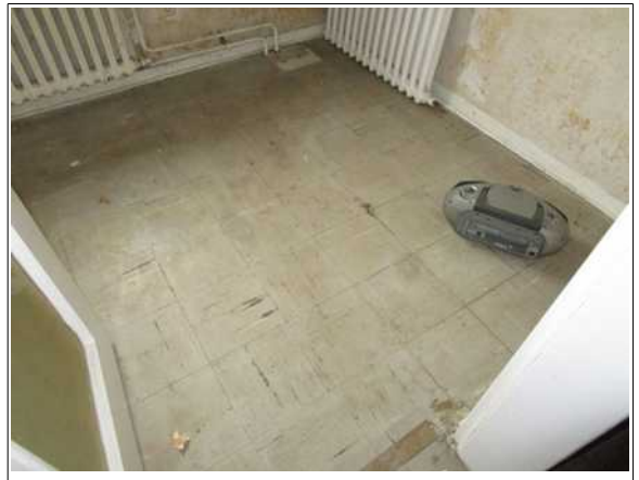
Abbildung 8: Wohngebäude Floor-Flex Platten
