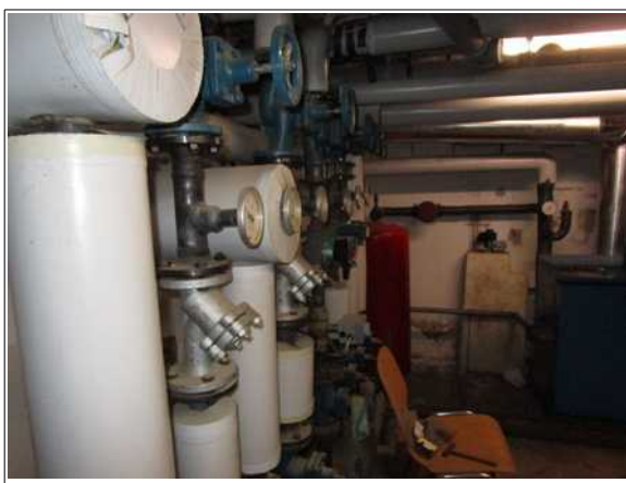
Abbildung 5: Keller Gebäude aha
