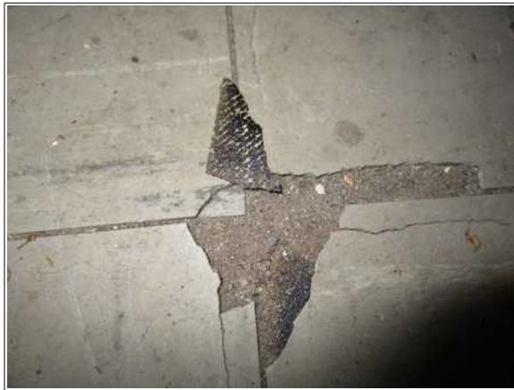
Abbildung 9: Wohngebäude Kleber unter Floor-Flex Platten
