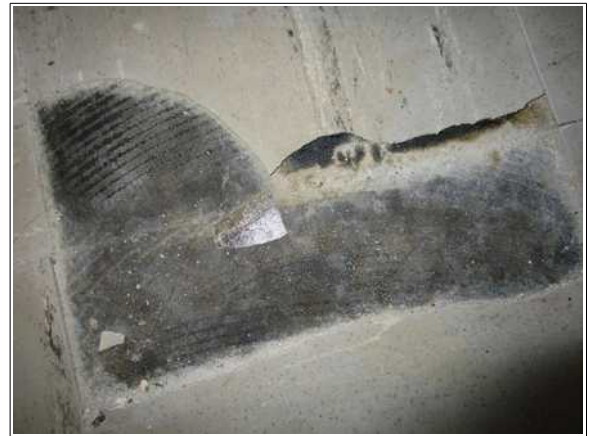
Abbildung 10: Wohngebäude Kleber unter Floor-Flex Platten
