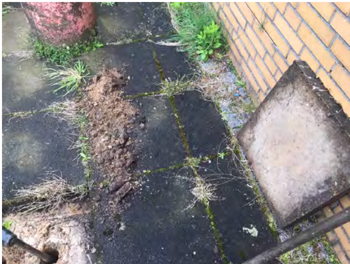
Vorschachtung am Bohrpunkt B1
