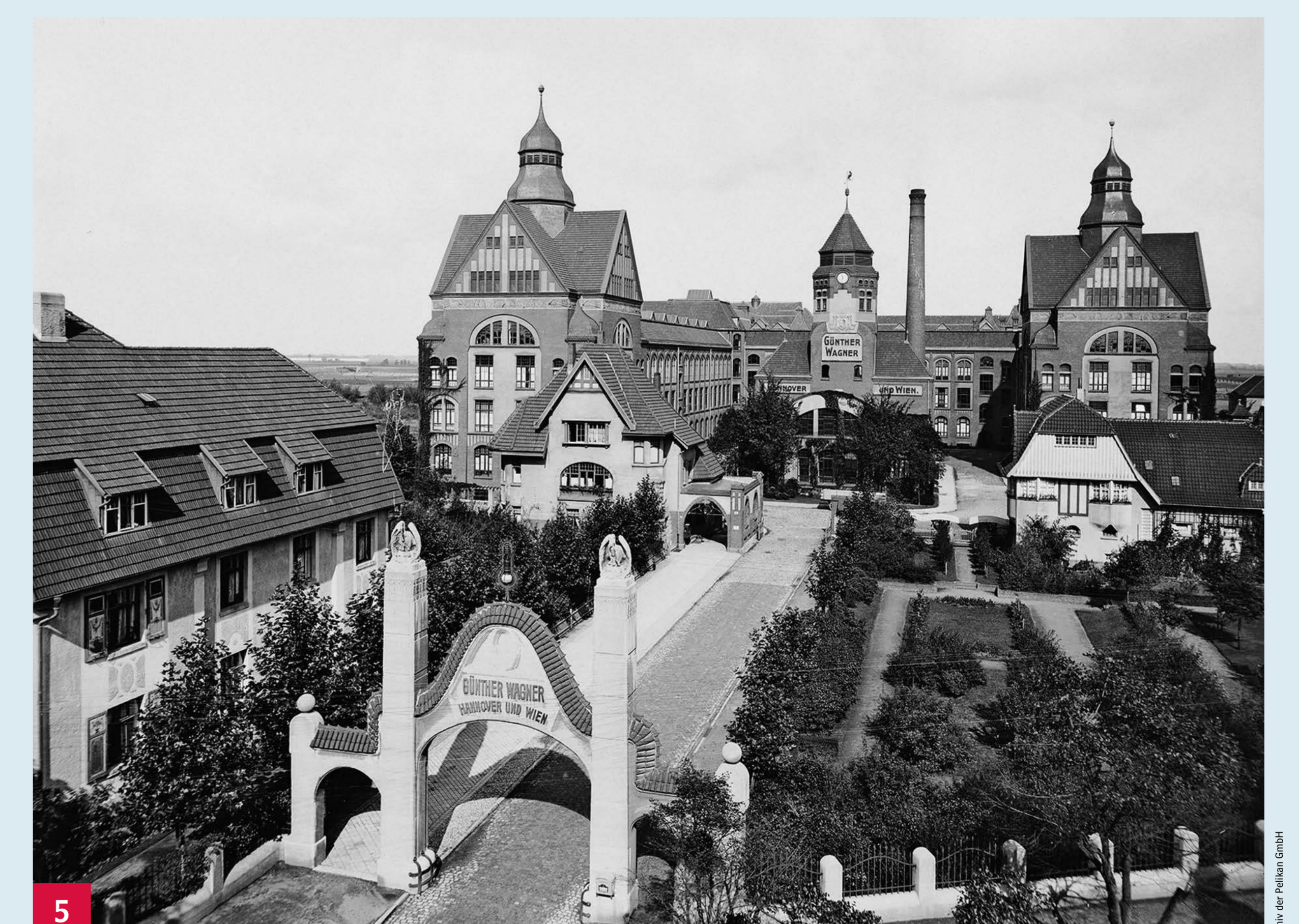
Ansicht der Verwaltungs- und Fabrikgebäude der Günther Wagner Pelikan-Werke in der Podbielskistraße, 1906.
