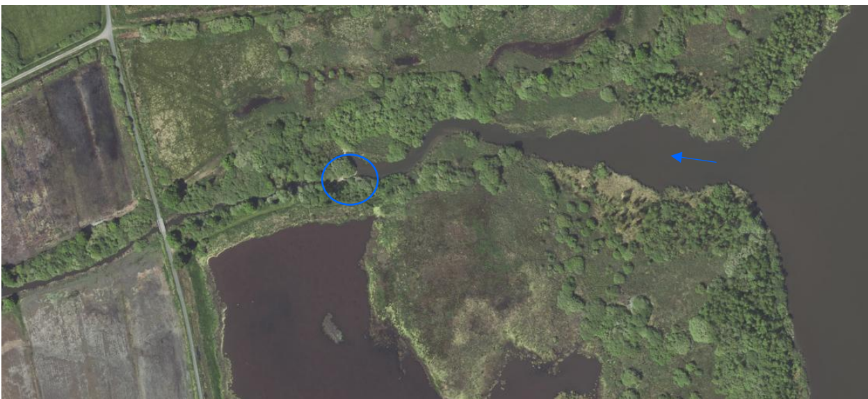
Abbildung 9-1: Luftbildaufnahme des Steinhuder Meerbachs am Auslaufs des Steinhuder Meeres; der blaue Pfeil zeigt die Fließrichtung und der blaue Kreis zeigt die Lage des Abschlussbauwerk, Quelle: ArL (2025)
