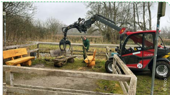
Der Teleskoplader als Hebehilfe
