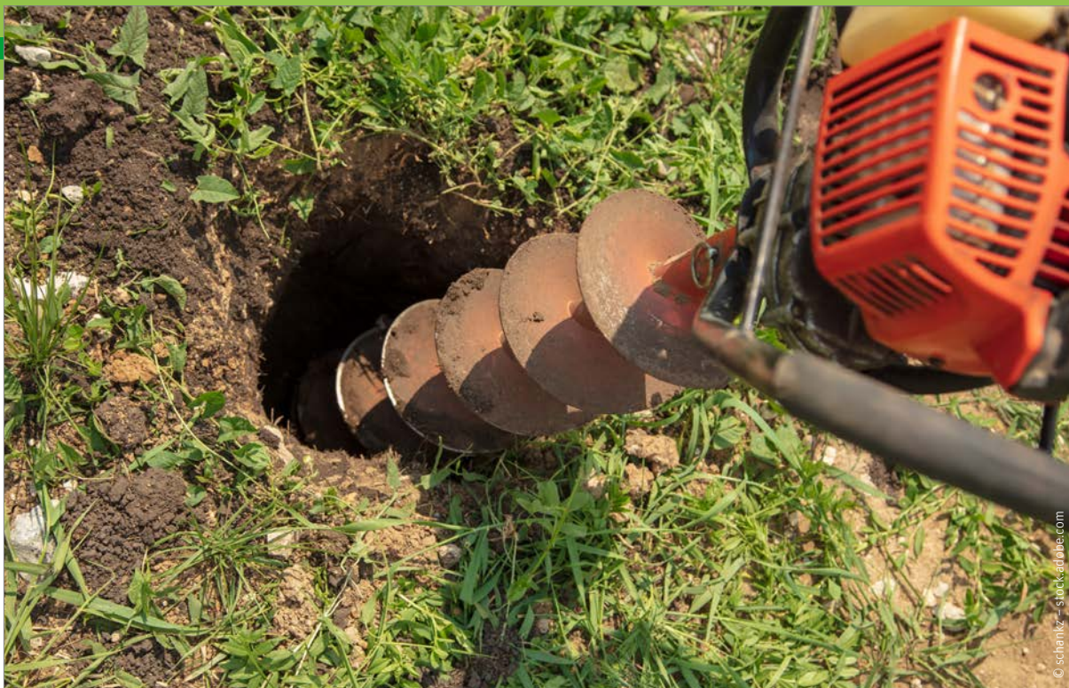
Brunnenbohrung mit einem Erdbohrer
