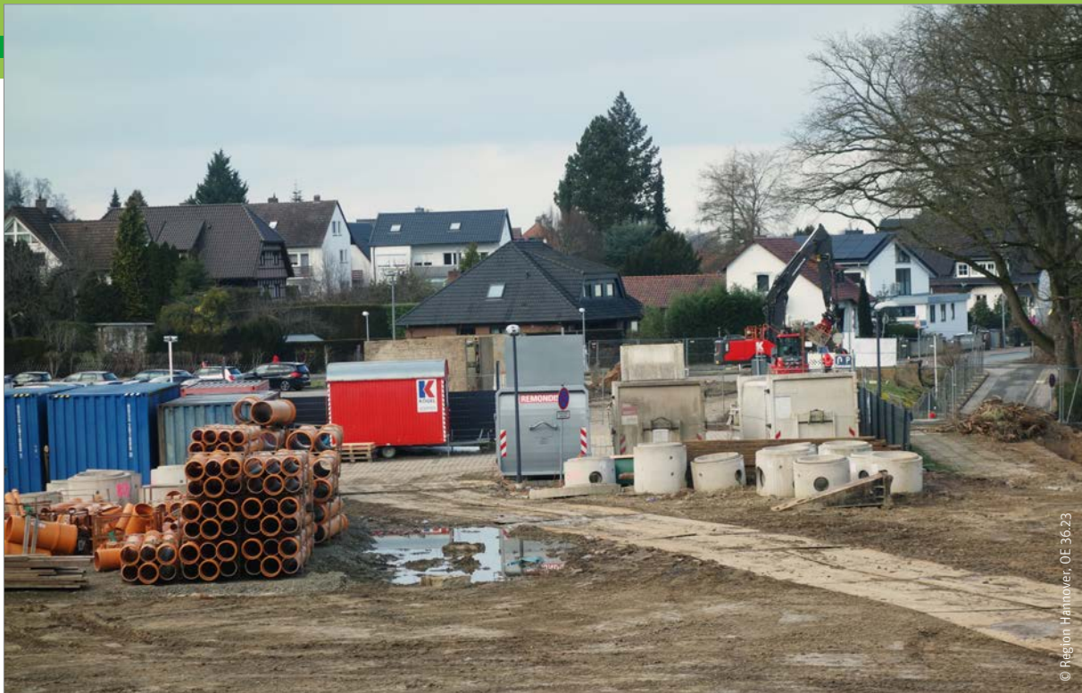
Typische Ausgangslage für eine Schallmessung infolge fehlender Beachtung des Schallschutzes beim Baustellenbetrieb
