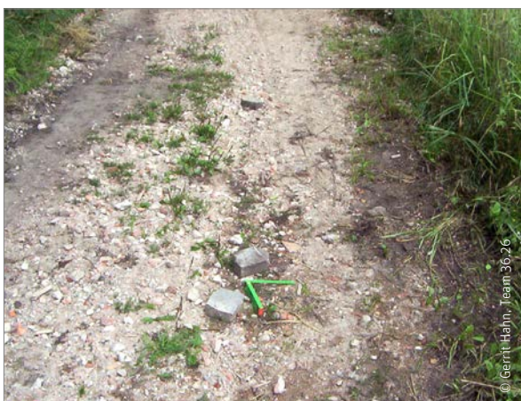
Grobes RC-Material mit Stolperstellen
