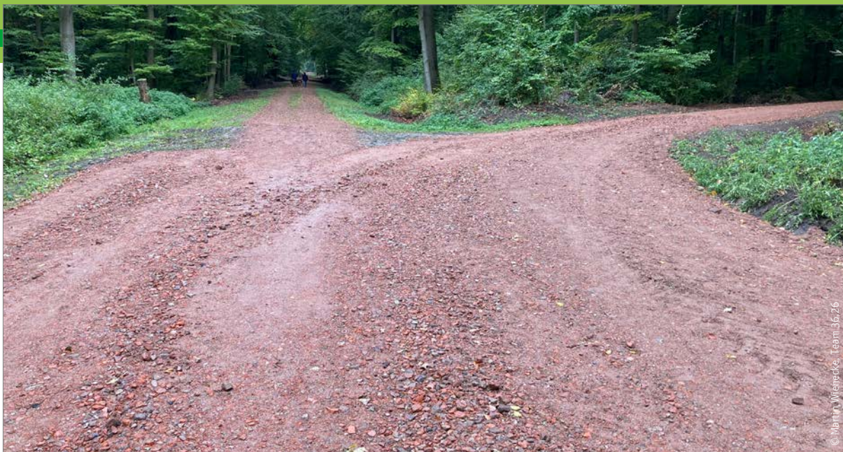
Wegebefestigung mit RC-Baustoff
