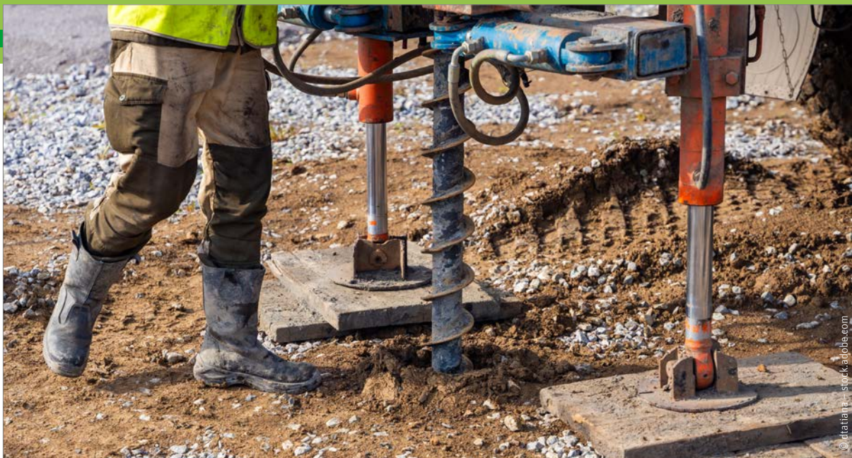
Schneckenbohrung im Rahmen einer Orientierenden Untersuchung
