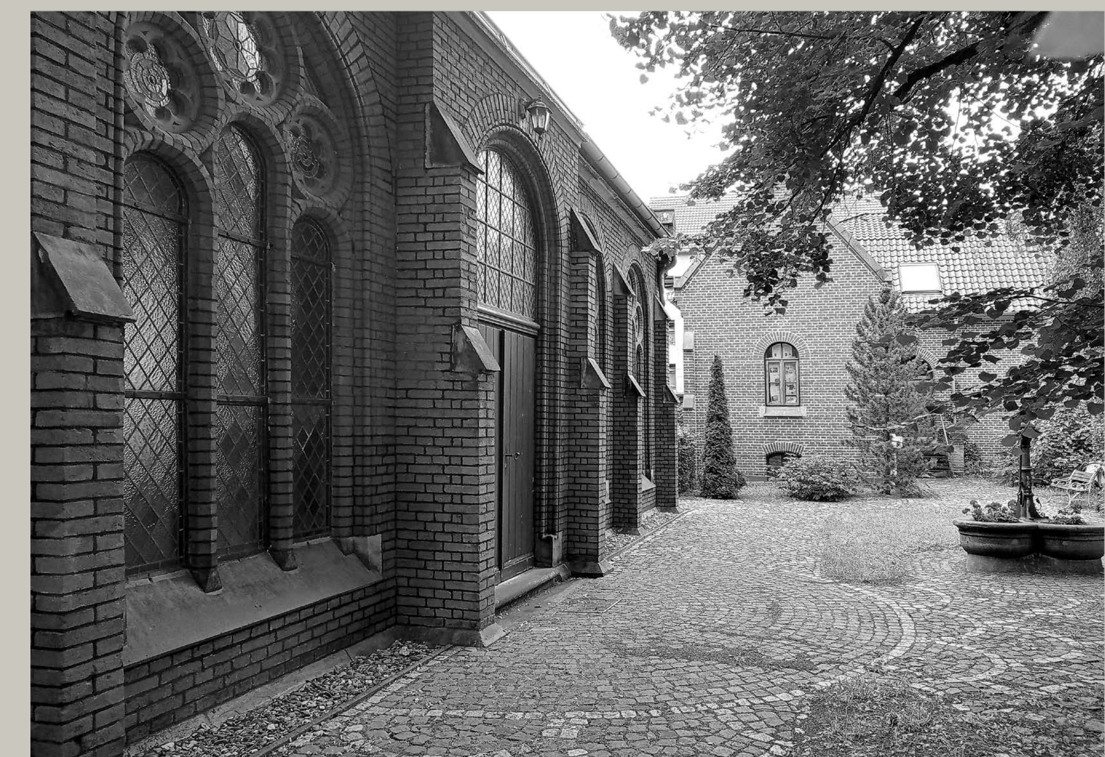
Der Eingangshof mit Predigthalle und Wohnhaus
