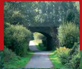
Brücke der Güterumgehungsbahn
