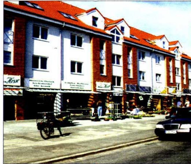
Wohn- und Geschäftshaus, Ricklinger Straße
