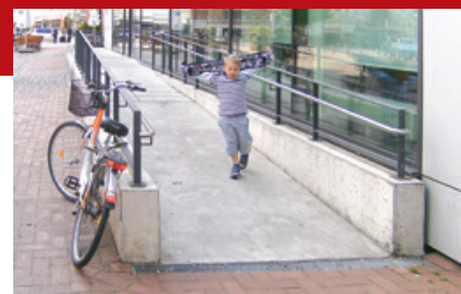
RATHAUS LINDEN RAMPE AM HAUPEINGANG
