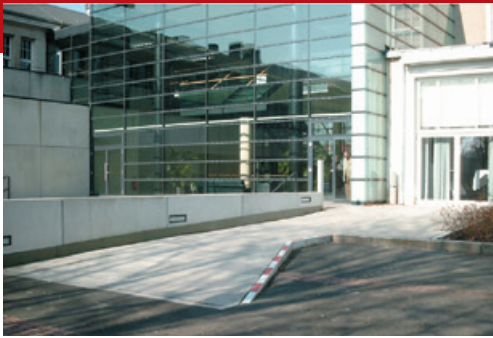
HANNOVER CONGRESS CENTRUM FLACHE ANBÖSCHUNG AUF DIE TERRASSE
