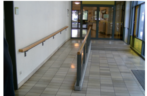
PESTALOZZI-GRUNDSCHULE RAMPE IM FLUR
