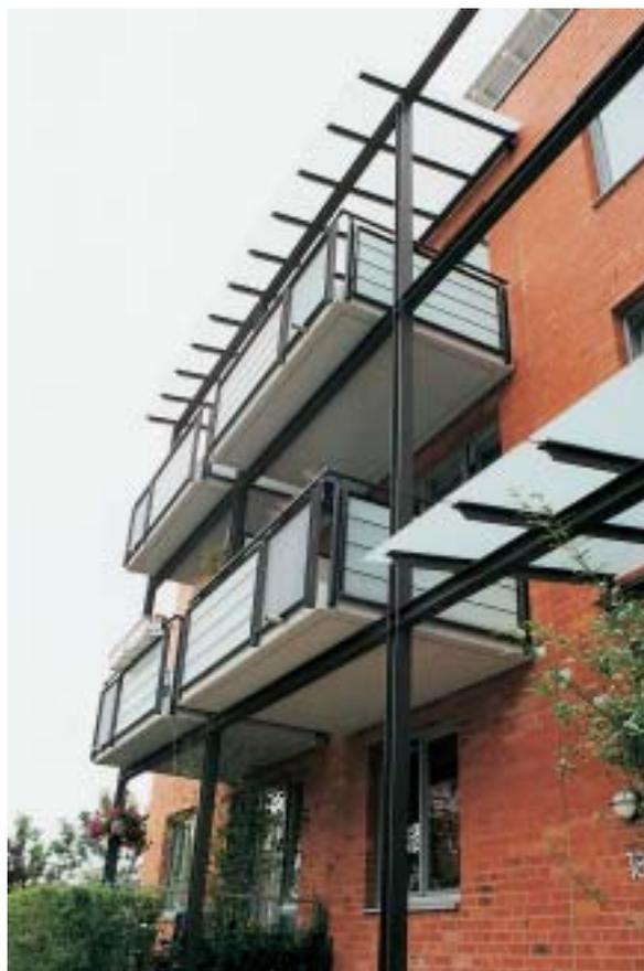
*Traitement des entrées et balcons visant à réduire les ponts thermiques et l'humidité*
