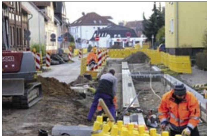
Während der Bauarbeiten war ein Teil der Freudenthalstraße nur eingeschränkt zu befahren.
