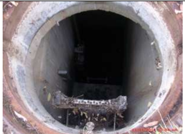
Schieberdrossel und ehemaliger Überlauf (zubetoniert)
