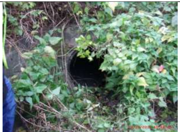
Linker Durchlass DN 800 in RRB Wülfeler Straße, links Rinne Böschungsentwässerung
