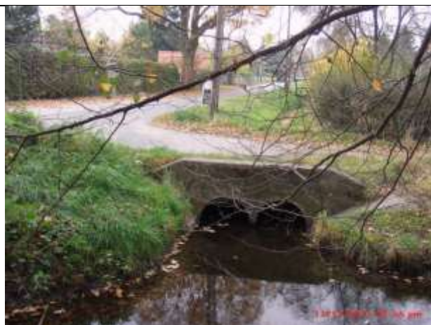
Mündung in den Landwehrgraben über 2 Durchlässe DN 800
