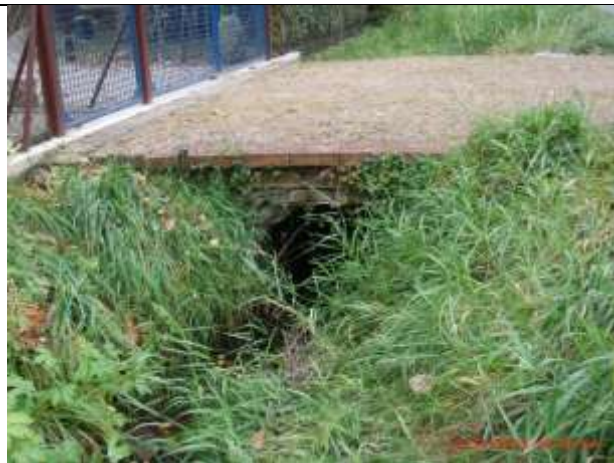
Durchlass DN 800 unter Grundstückszufahrt (oberhalb)
