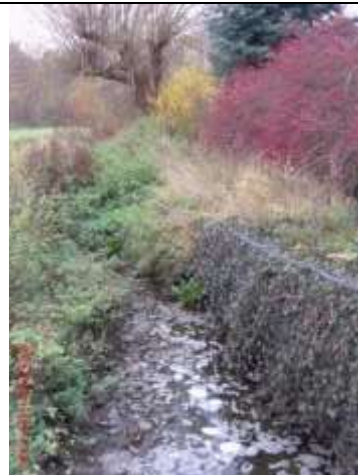
Böschungsbefestigung mit Gabionen
