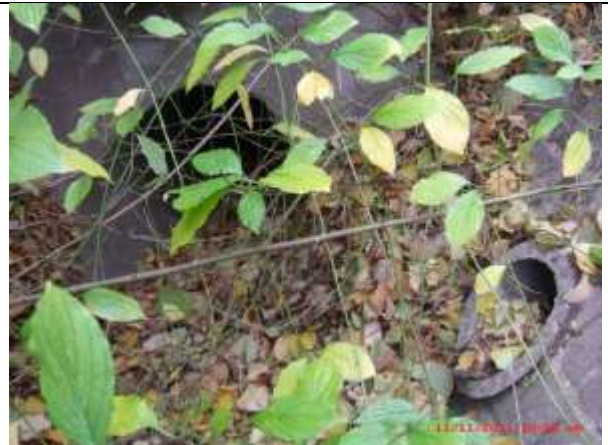
Rechter Durchlass DN 800 in RRB Wülfeler Straße, rechts Einleitung DN 200
