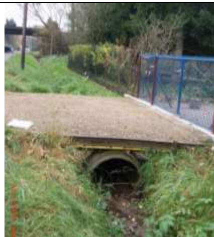
Durchlass DN 800 unter Grundstückszufahrt (unterhalb)
