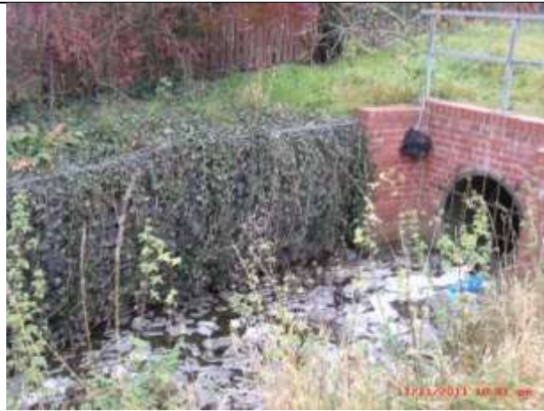
Übergang Verrohrter Seelhorstgraben bzw. RW-Kanal DN 900 in Seelhorstgraben
