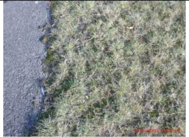
Fahrbahnbefestigung Asphalt, Parkplätze Schotterrassen
