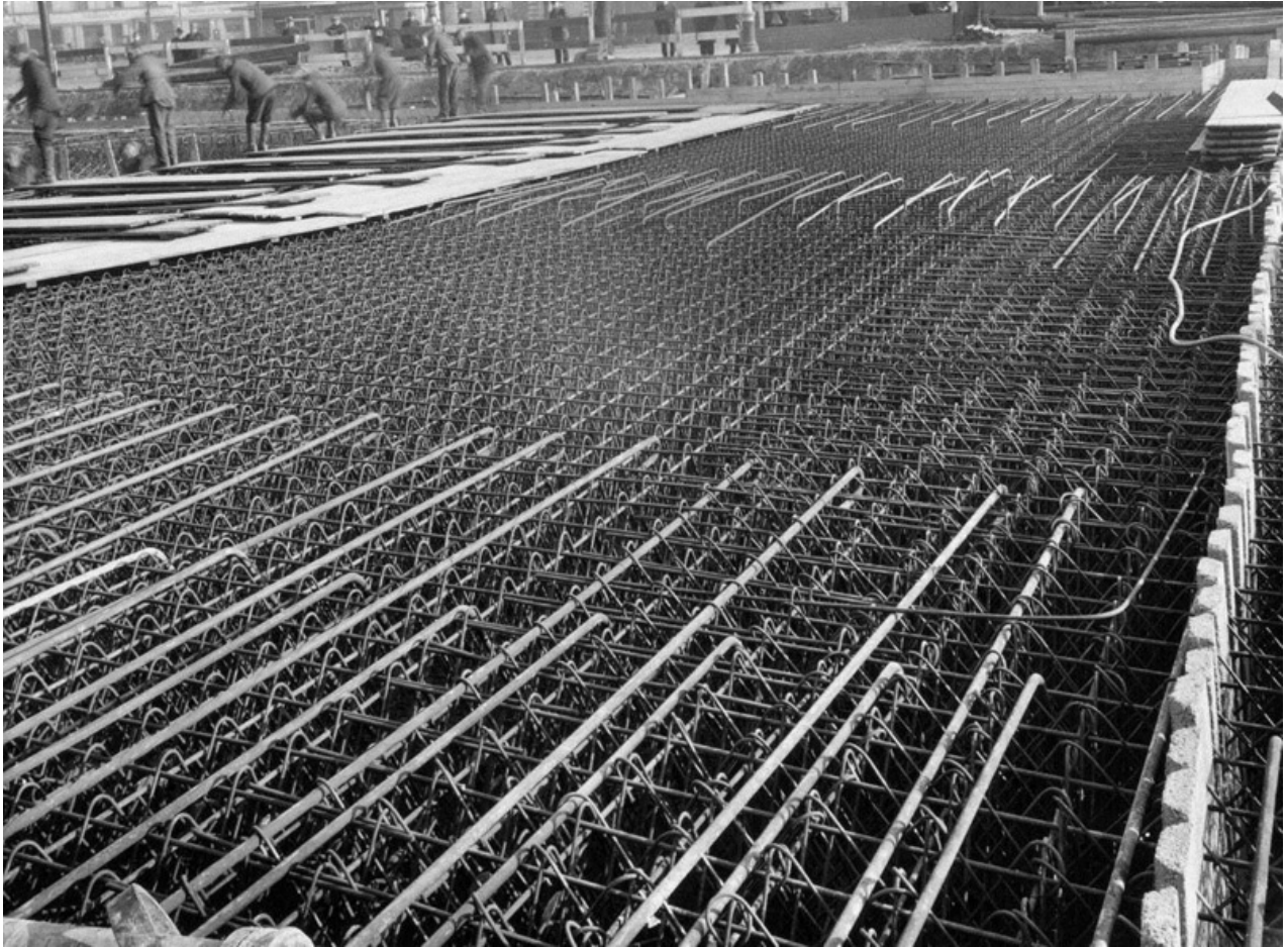
Oben: Stahldrahtmatten als Bewehrung der Bunkerdecke vor der Auffüllung mit Beton; im Hintergrund Kriegsgefangene als Zwangsarbeiter auf der Klagesmarkt-Baustelle, wahrscheinlich Anfang 1941 (Quelle: HMM).
