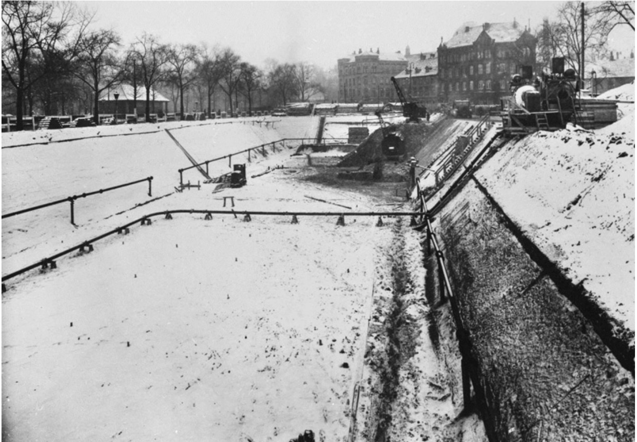
Oben: Baugrube am Klagesmarkt, Blick nach Süden, Winter 1940/41 (Quelle: Historisches Museum Hannover [HMH]).
