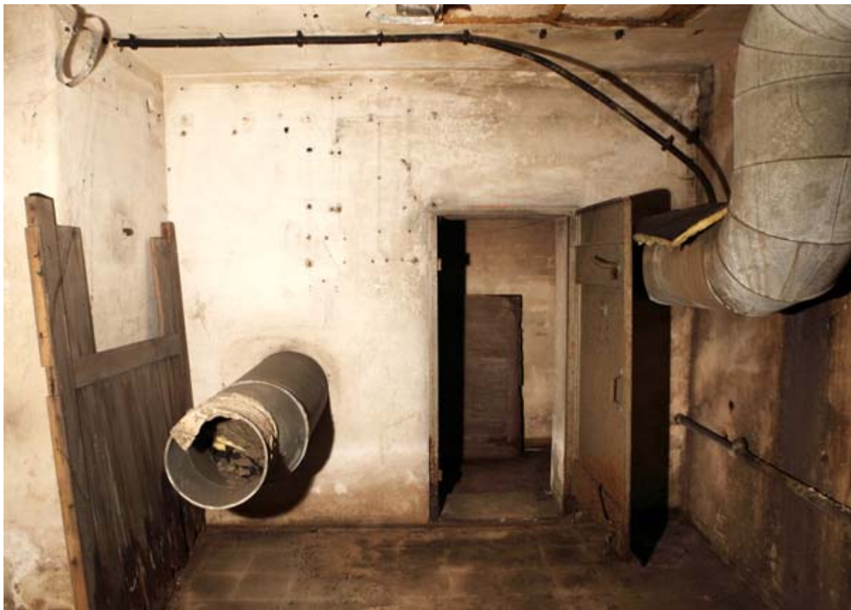
Oben: Reste der Belüftungsanlage, Zustand am 2. Mai 2013 (Quelle: Geoinformation Hannover).
