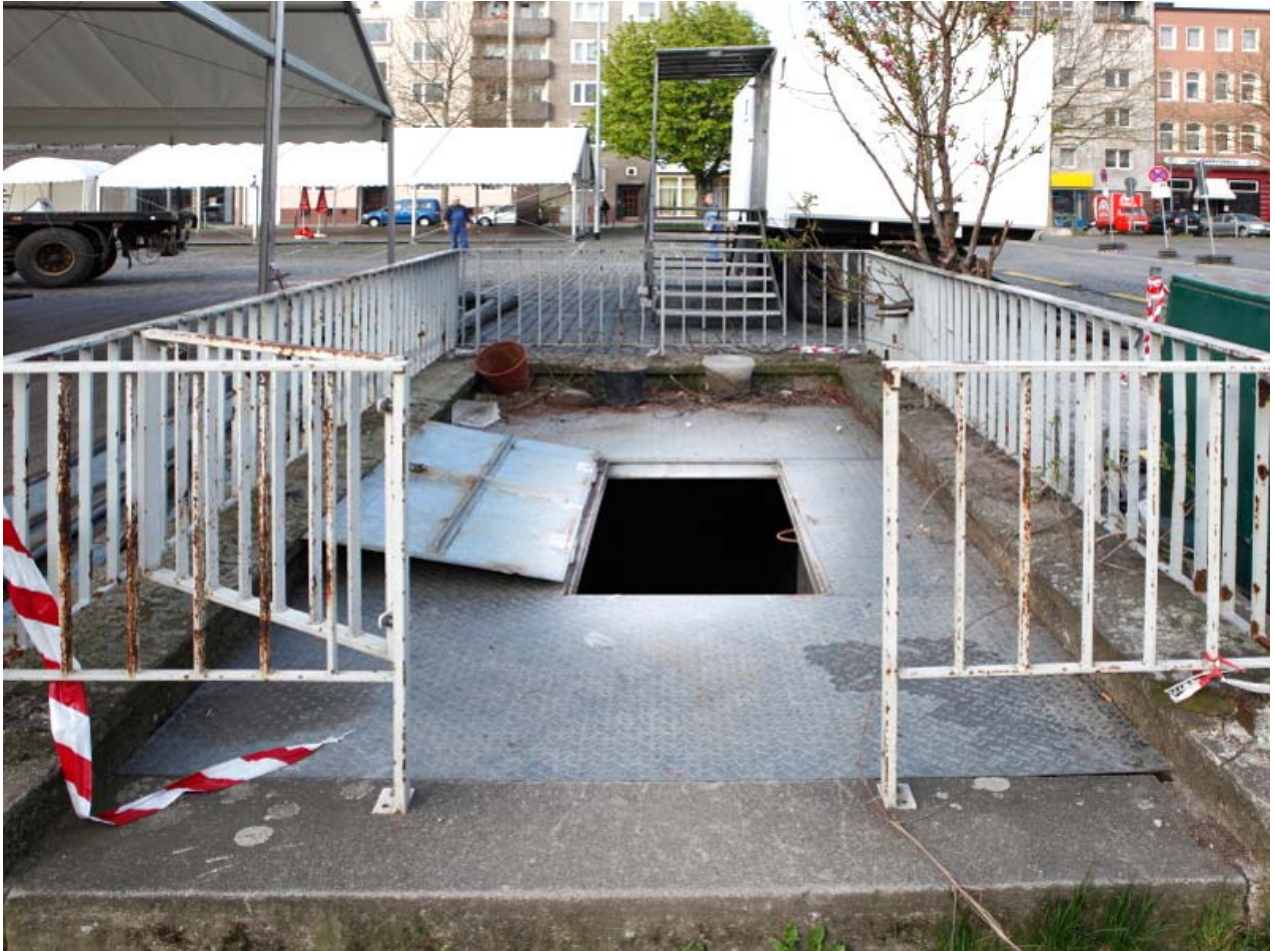
Oben: Nordeingang des Bunkers mit geöffneter Abdeckplatte, Zustand am 2. Mai 2013 (Quelle: Geoinformation Hannover).
