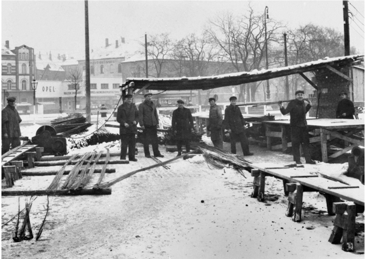
Oben: Arbeiter auf der Baustelle am Klagesmarkt, Winter 1940/41 (Quelle: HMH).
