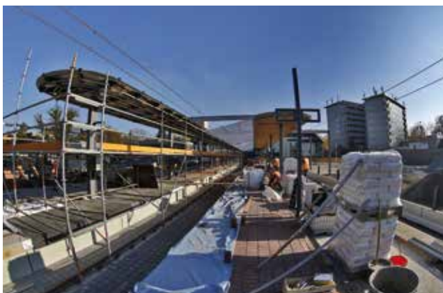
Im November wurde noch gebaut: Zum Fahrplanwechsel ist die Umsteigeanlage fertig geworden
