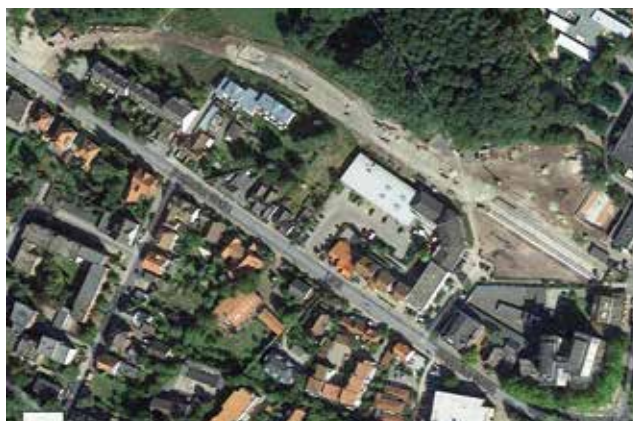
Aus der Luft deutlich erkennbar: der Trassenverlauf zwischen der Station „Am Forstkamp“ und dem Endpunkt
