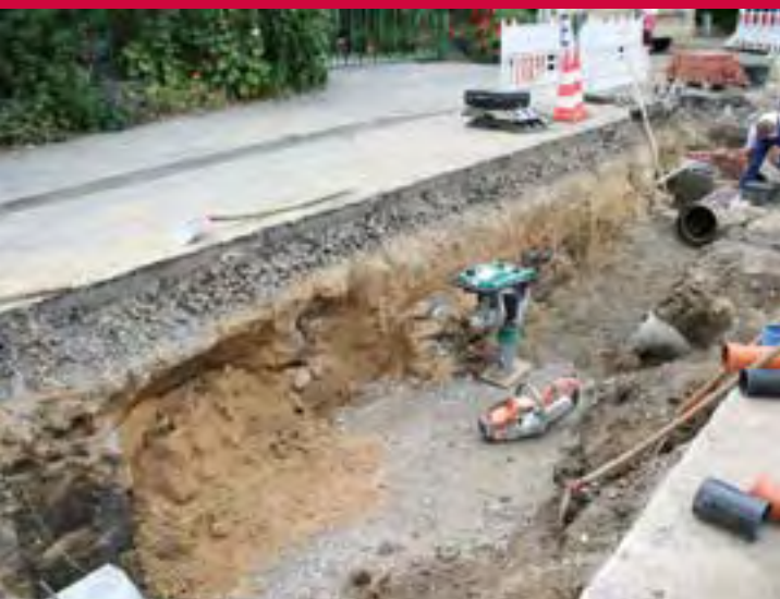
Typischer Straßenaufbruch mit Bauschuttanteilen im Unterbau
