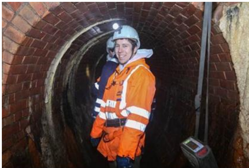
Einblicke in einen rund 100 Jahre alten Kanal in Hannovers Nordstadt
