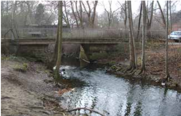
Ihme im Ricklinger Holz, Brücke Mühlenholzweg an der B3
