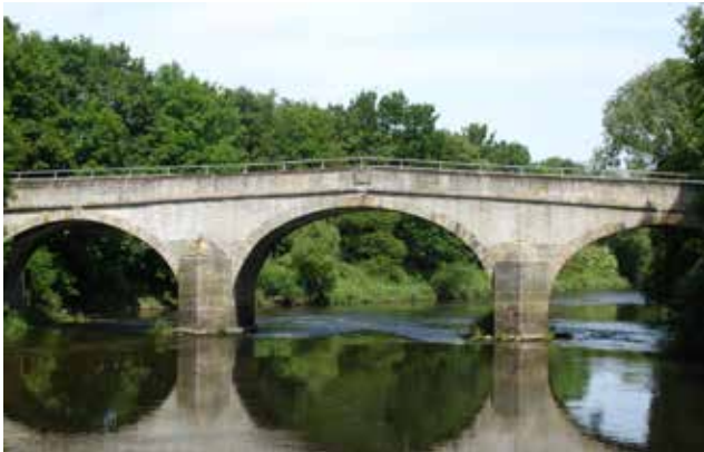
Calenberger Leine-Dreibogenbrücke von 1751 (L460)
