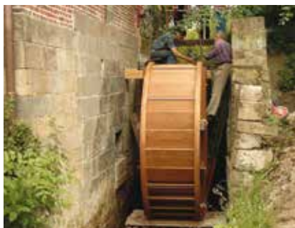
Wassermühle Wightinghausen, Einbau eines neuen Mühlrades (Foto: M. Barth)
