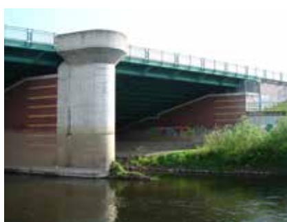
Mittellandkanal-Trogbrücke über die Leine
