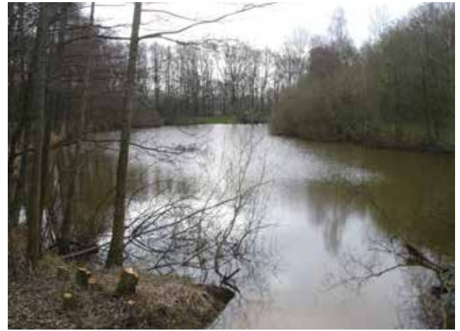
Regenrückhaltebecken in Garbsen
