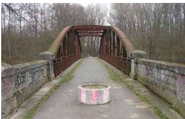
Wegebrücke über den Stichkanal (Route R13)
