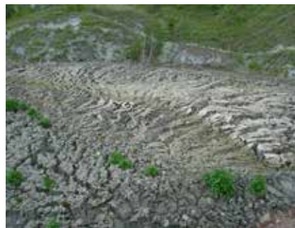
Aufschüttungen am Seeufer
