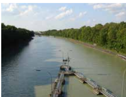
Mittellandkanal an der Schleuse Anderten
