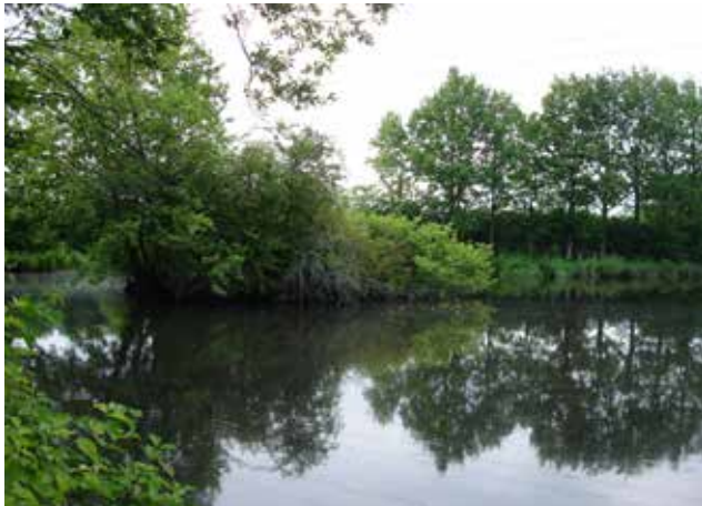
Regenrückhaltebecken an der Haferriede nördlich von Gehrden
