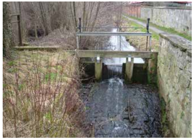
An der ehemaligen Wassermühle am Rittergut in Bredenbeck
