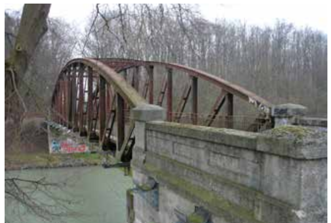
Alte Stahlträger-Fachwerkbrücke über den Zweigkanal Hildesheim bei Bolzum
