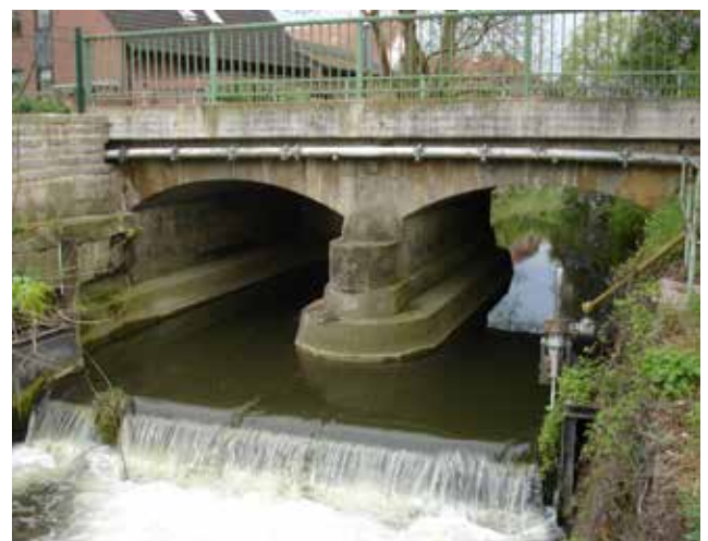
Straßenbrücke über die Westaue in Bokeloh
