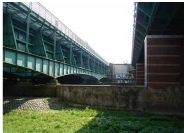
Die zwei Kanal-Trogbrücken über die Leine bei Lohnde
