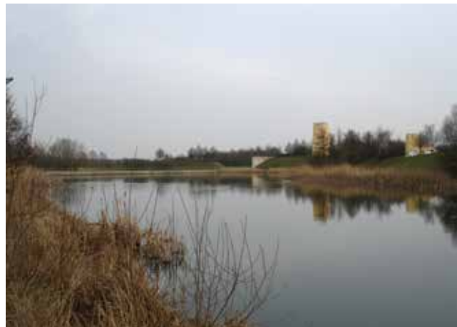
Regenrückhaltebecken / Teich am Südrand des ehemaligen EXPO-Geländes
