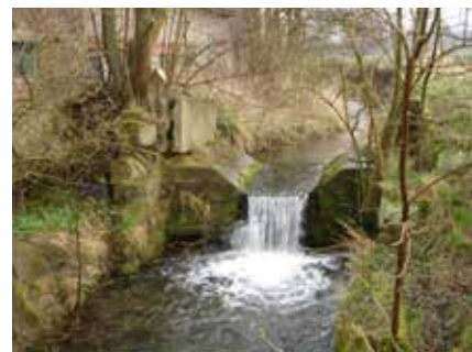
Sohlabsturz an der ehemaligen Sägemühle, Sedemünder Mühlbach, Springe
