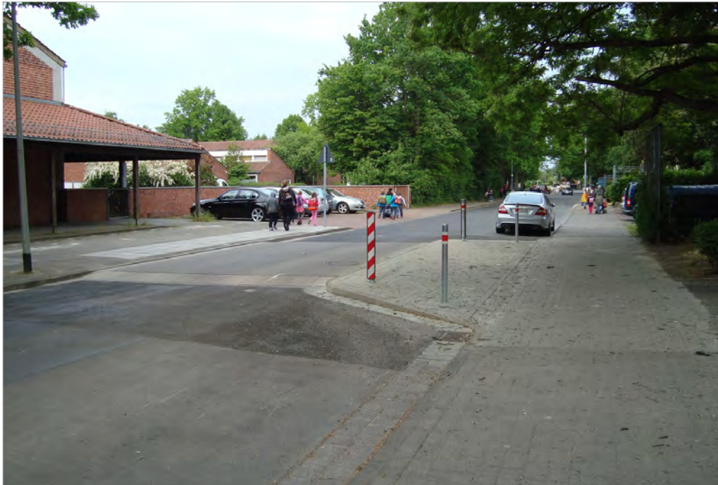
Umgestaltung einer Fußgängerquerung vor der Grundschule Hägewiesen (LHH)
