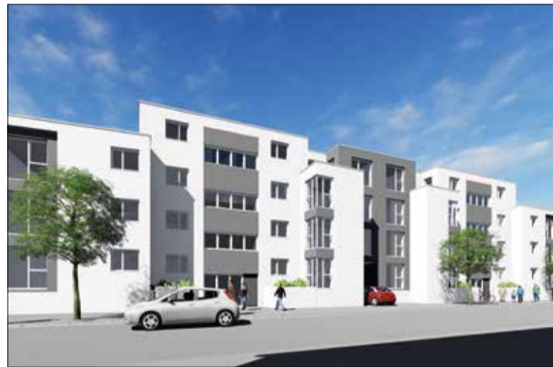
Einen hellen und einladenden Eindruck vermittelt die Fassade des neuen Wohnhauses, das an der Weizenfeldstraße gebaut wird. Bild: Lindschulte Ingenieurgesellschaft
