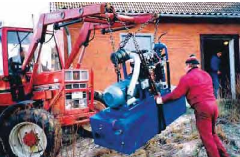
► Einbau des BHKWs auf dem Becke Hof
