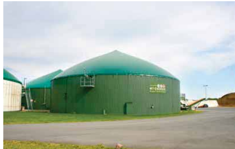
► Gärbehälter der Biogasanlage in Thönse
