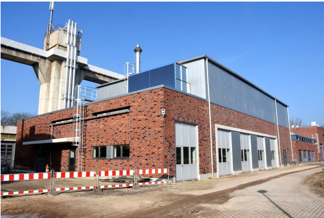
Die Maschinenhalle des Blockheizkraftwerkes von außen
