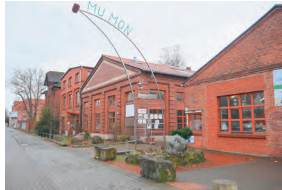
Abb. 49: Ehemalige Fuchswerke, Badenstedt
