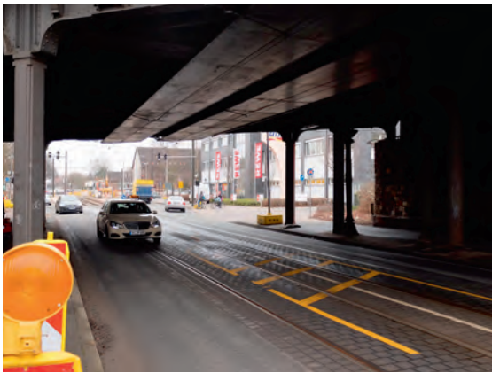
Abb. 35: Bahnunterführung Badenstedter Straße, Badenstedt
