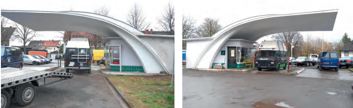
Abb. 55: Ehemalige Caltex-Tankstelle in Badenstedt
